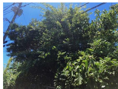
①電線に木がかかっています
