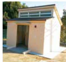
▲安北支部で設置された公園のトイレ
